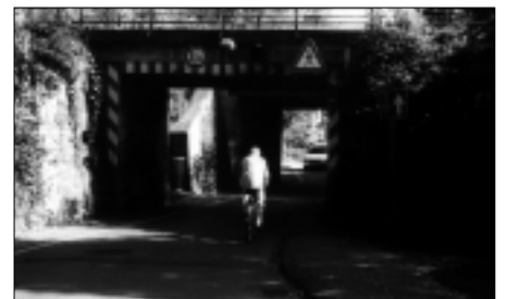
Mit geringem Aufwand Gefahr und Trostlosigkeit beseitigen: Die Unterführung an der Wackerstraße.
