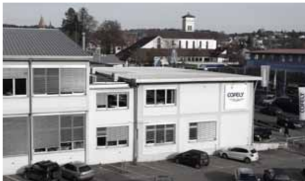
Blick vom Cofely-Gelände Richtung Reutin. Foto: K.S.
